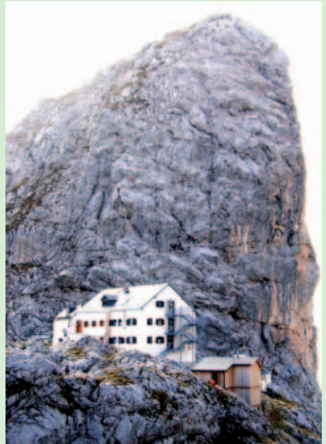
Riemannhaus mit Sommerstein und Brandschutz-treppe.
