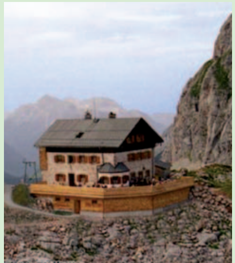
Ingolstädter-Haus nach Umbau mit neuer Terrasse.
