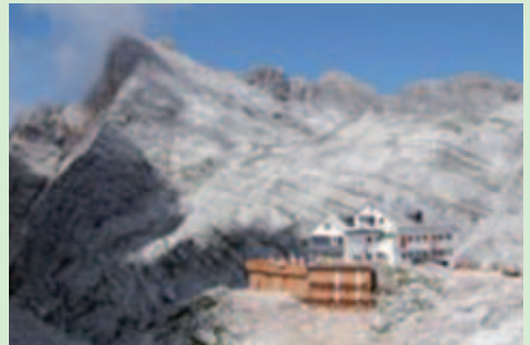
Riemannhaus nach Umbau mit neuer Terrasse.
